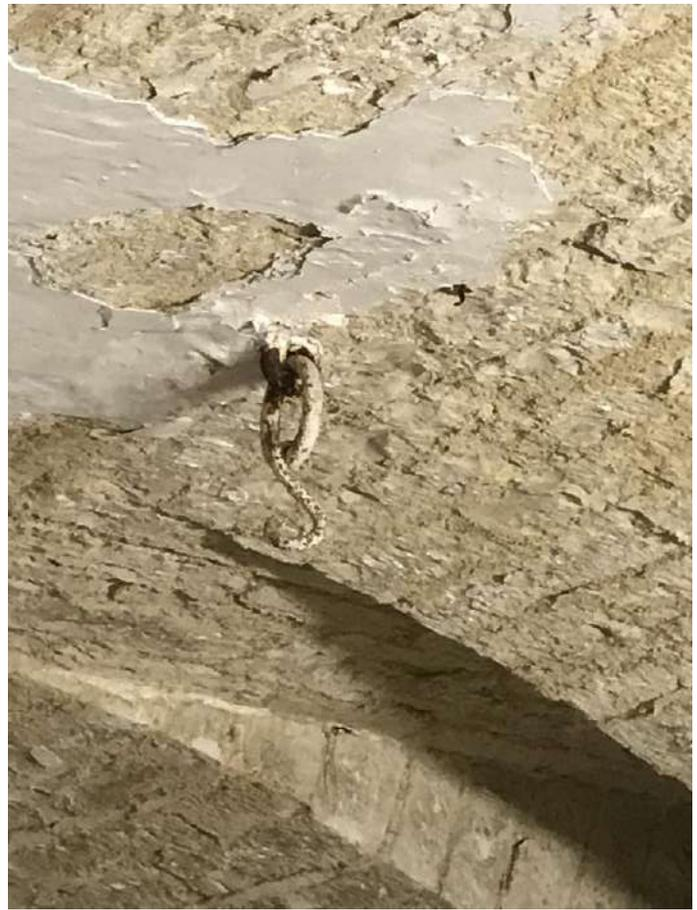
Lichtschalter und Steckdose in Räumen C2 bis C-8 (links). Massiver Deckenring zur Befestigung von Installationen in den Nischen (rechts).
